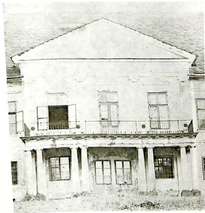
Altana na glavnom pročelju dvorca Golubovca podignuta 1820. god.
